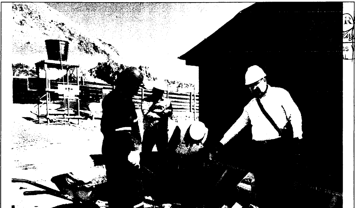
Foto N° 14: EXTRACCION DE LA MUESTRA DE CONCRETO EN VACIADO DE ZAPATAS PARA LUEGO REALIZAR EL ENSAYO DE RESISTENCIA A LA COMPRESION DEL CONCRETO.
