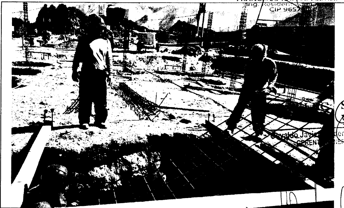
Foto N° 06: COLOCACION DE ACERO DE REFUERZO, EN LA ZAPATA TIPO Z-3 DEL MODULO
