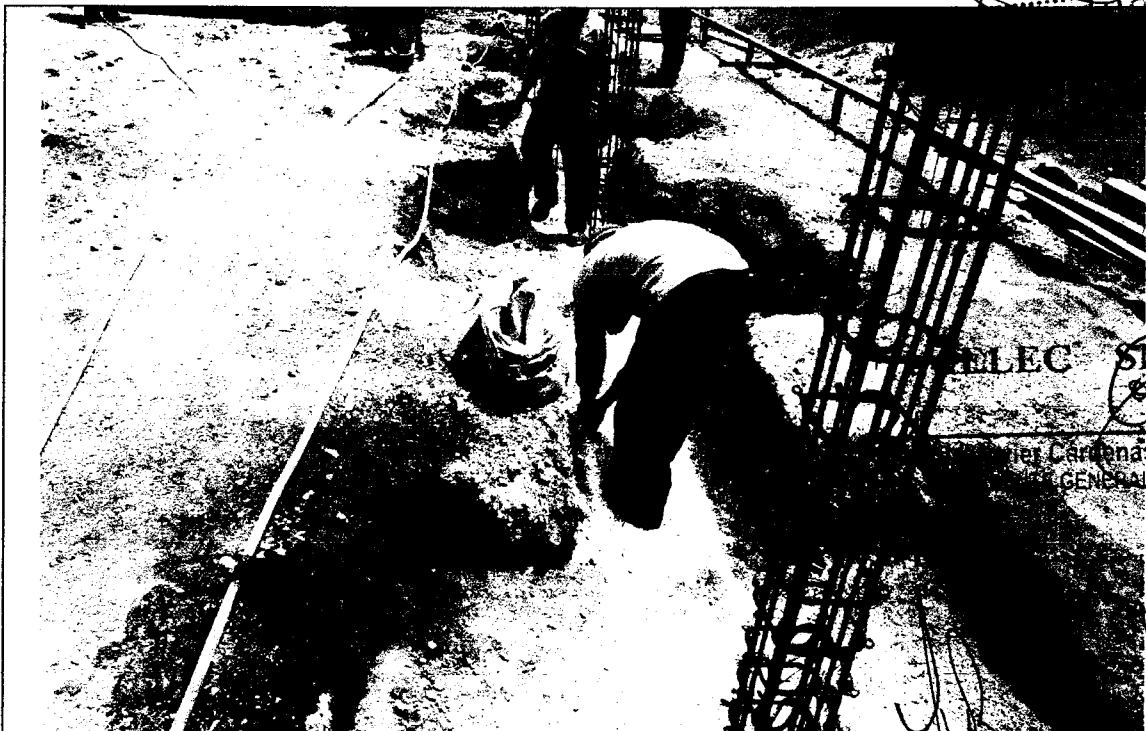
Foto N° 20: TRAZO PARA PROCEDER A LA EXCAVACION DE VIGAS DE CIMENTACION.
