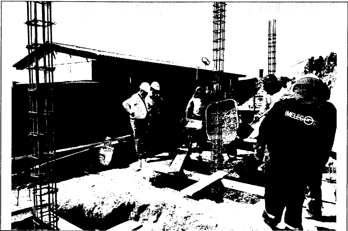
Foto N° 11: VACIADO DE CONCRETO F'C=210KG/CM2 EN ZAPATAS, EN PRESENCIA DEL SUPERVISOR Y RESIDENTE DE OBRA.
