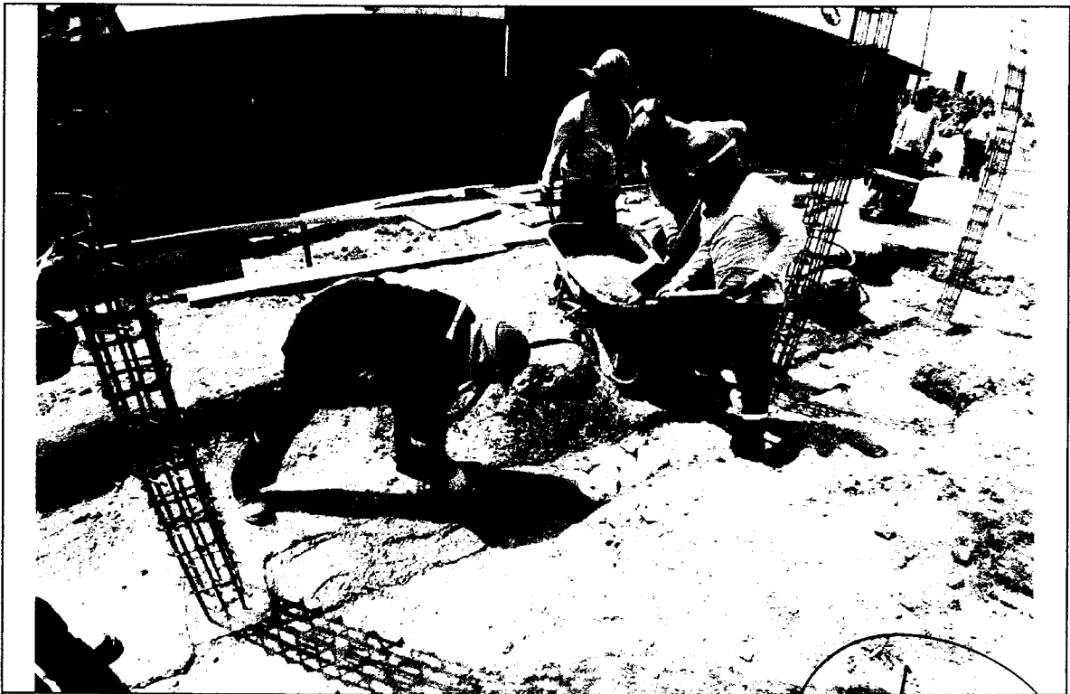
Foto N° 23: VACIADO DE SOLADO EN VIGAS DE CIMENTACION.
