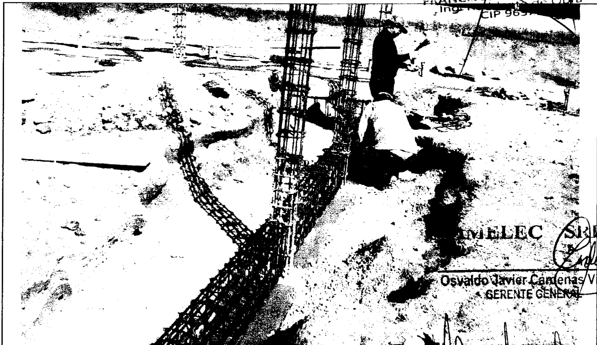
Foto N° 24: COLOCACION DE ACERO DE REFUERZO EN VIGAS DE CIMENTACION
