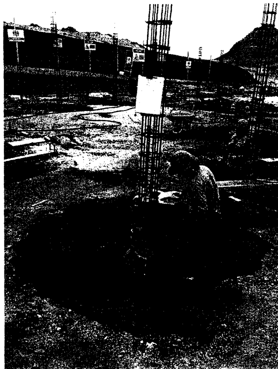
COMPACTADO PARA ZAPATAS. EPPs SEGÚN LA ACTIVIDAD
