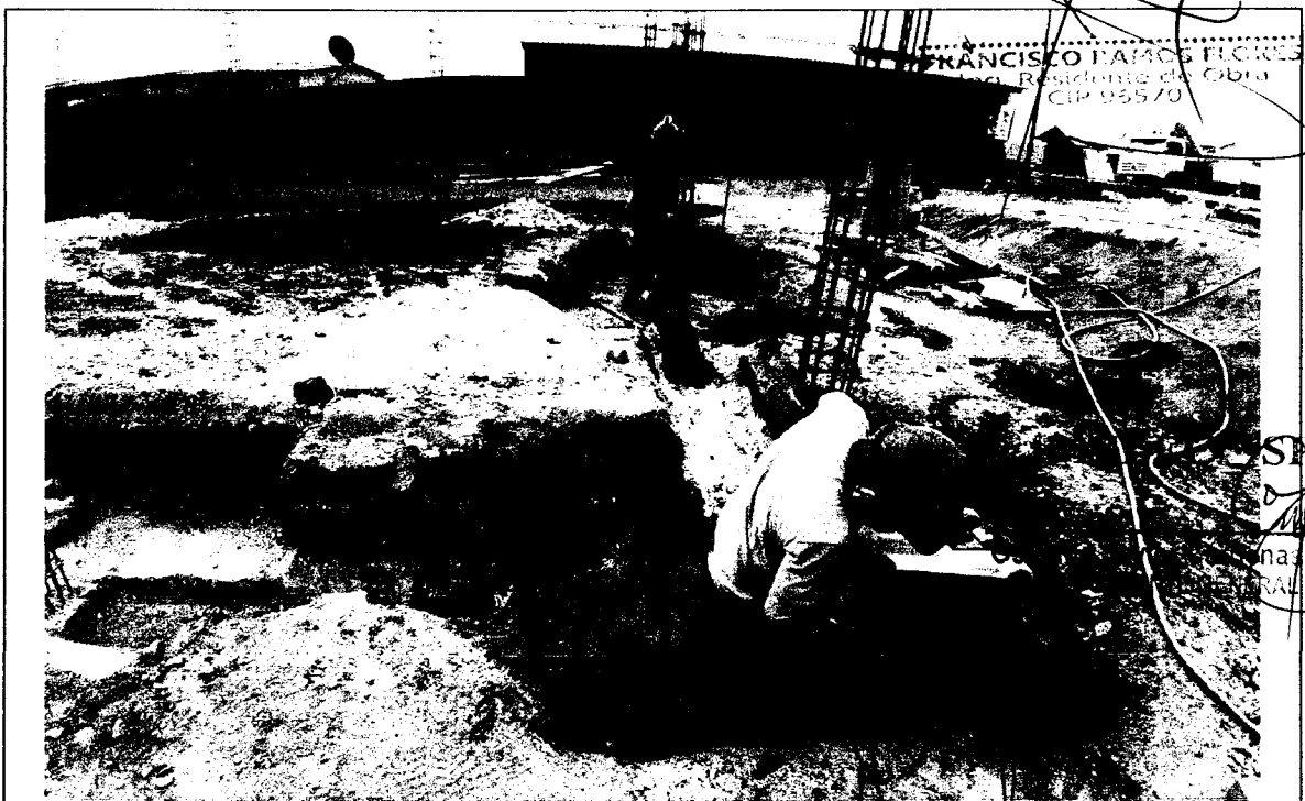
Foto N° 18: COMPACTACION DE RELLENO EN ZAPATAS CON CANGURO COMPACTADOR.
