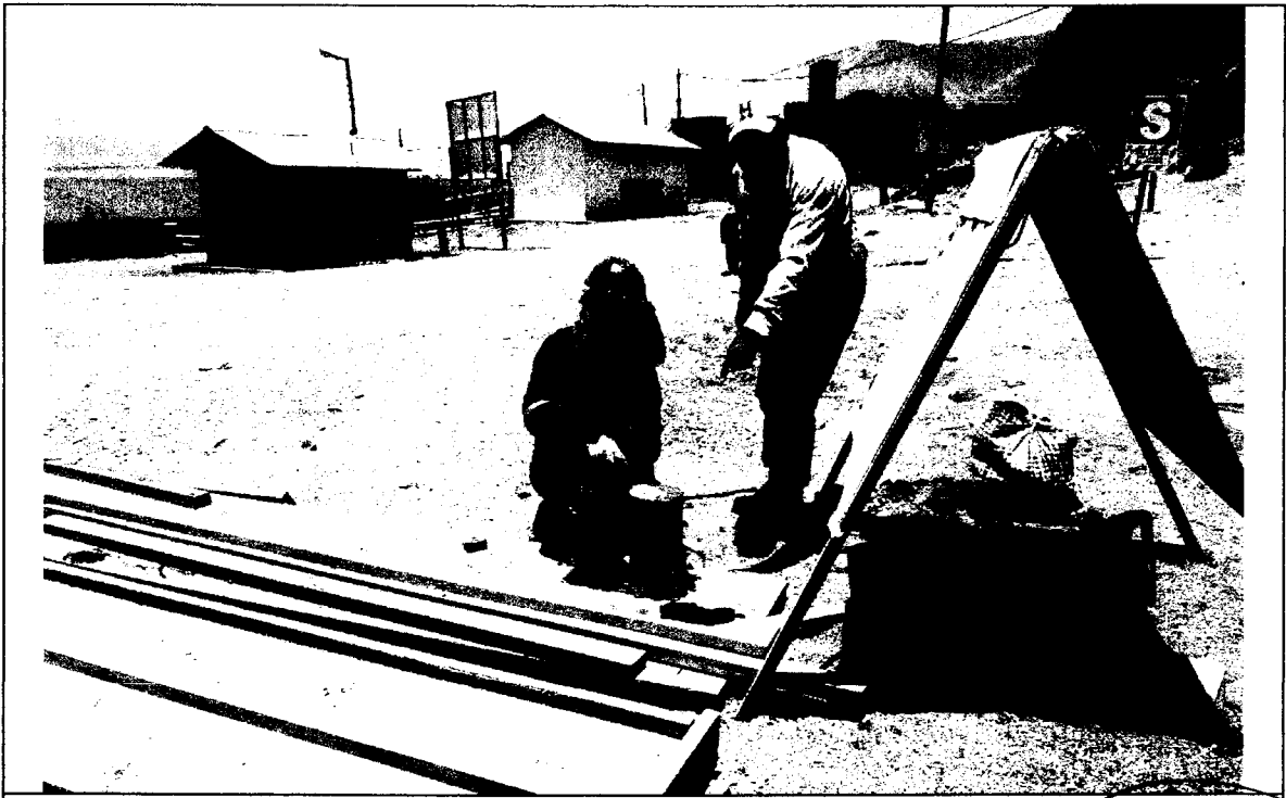
Foto N° 27: EXTRACCION DE LA MUESTRA DE CONCRETO EN VACIADO DE VIGAS DE CIMENTACION PARA LUEGO REALIZAR EL ENSAYO DE RESISTENCIA A LA COMPRESIÓN DEL CONCRETO.
