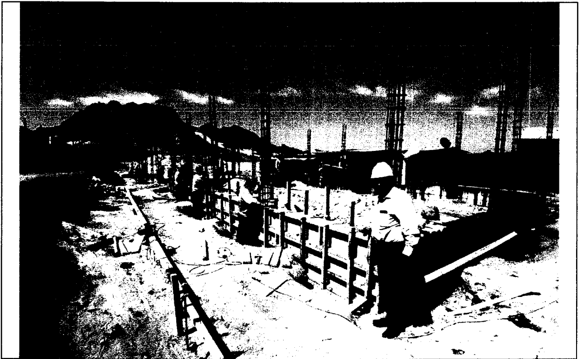
Foto N° 25: ENCOFRADO DE VIGAS DE CIMENTACION Y SOBRECIMIENTO DEL MÓDULO I.
