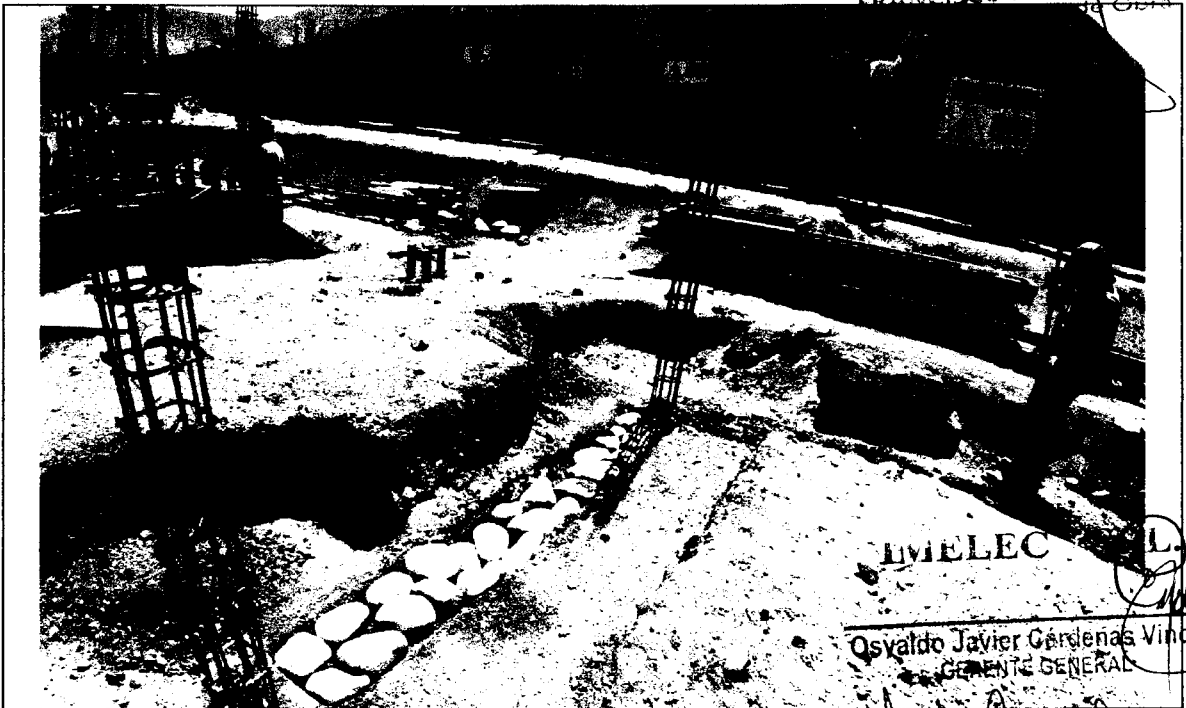
Foto N° 22: COLOCACION DE PIEDRAS PARA PROCEDER AL VACIADO DE SOLADO EN VIGAS DE CIMENTACION
