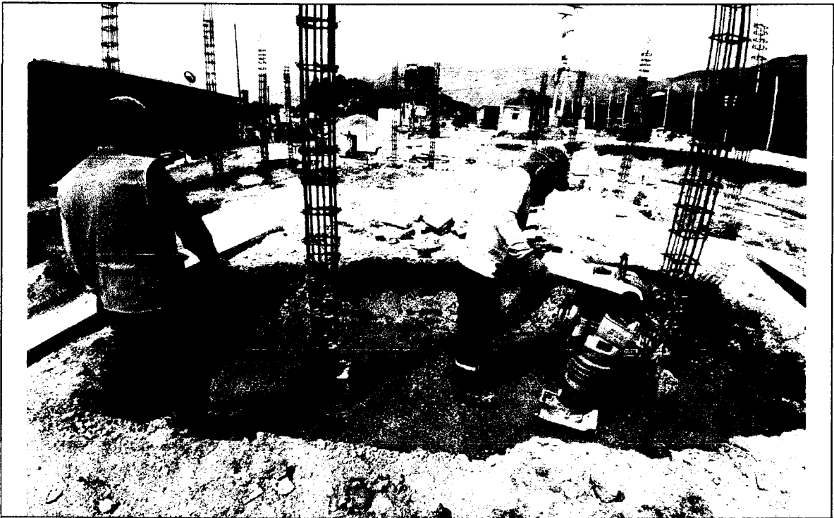
Foto N° 19: COMPACTACION DE RELLENO EN ZAPATA COMBINADA CON CANGURO COMPACTADOR.
