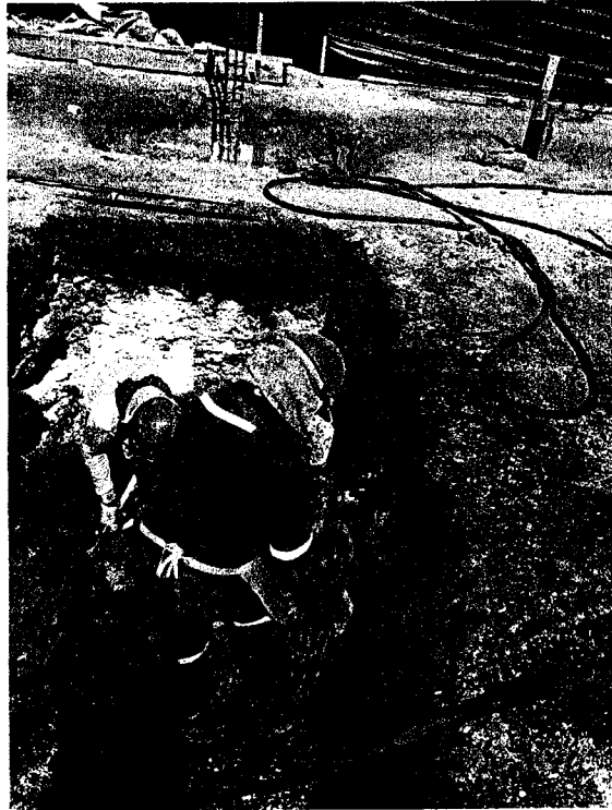
MARTILLADO DE ROCAS PARA ZAPATAS. EPPs SEGÚN LA ACTIVIDAD
