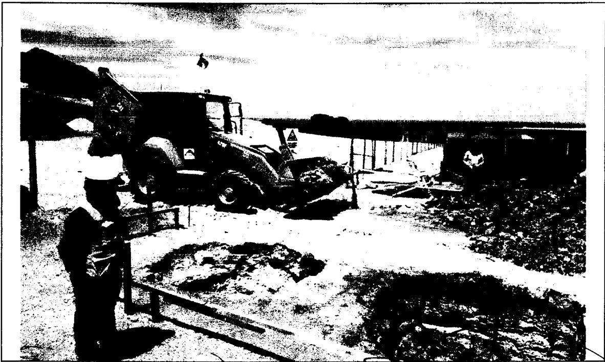
Foto N° 03: ACARREO DE MATERIAL EXCEDENTE CON RETROEXCAVADORA.
