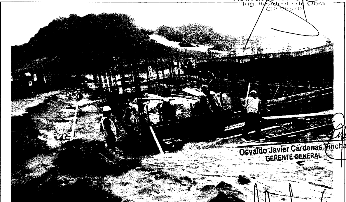
Foto N° 26: VACIADO DE CONCRETO F'C=210 KG/CM2 EN DE VIGAS DE CIMENTACION Y SOBRECIMIENTO DEL MÓDULO I.
