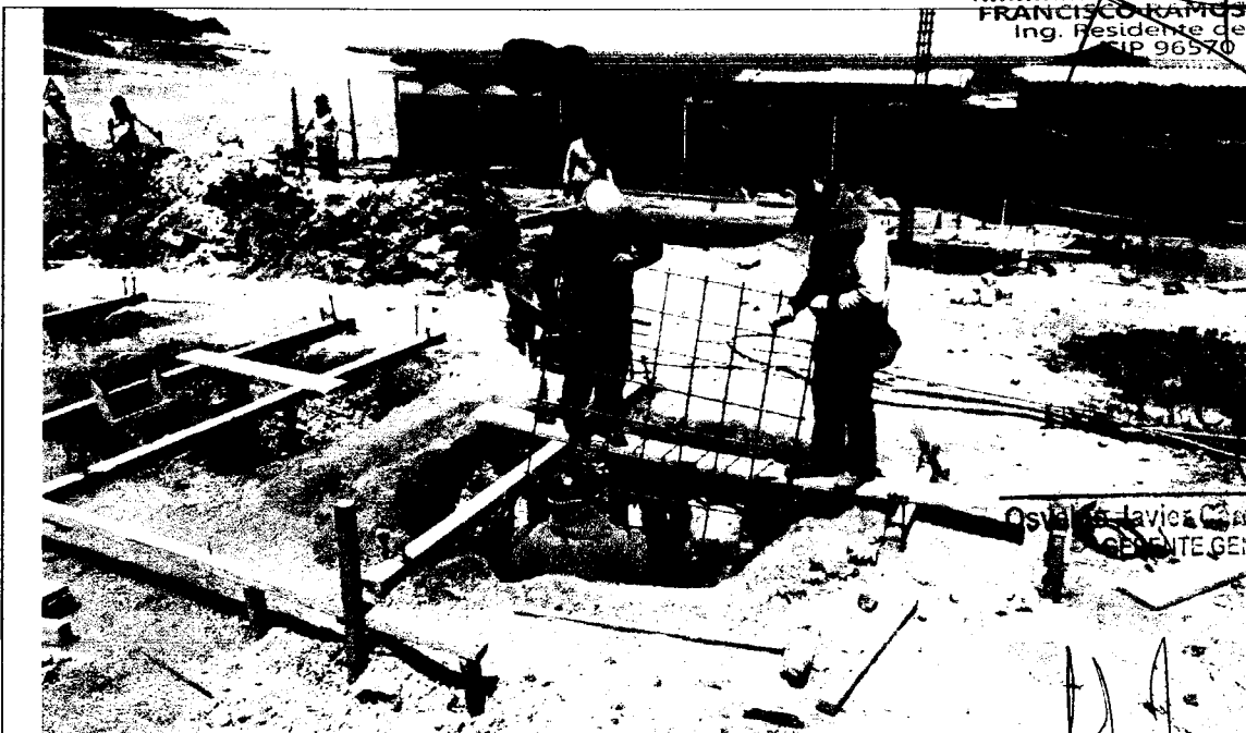
Foto N° 08: COLOCACION DE ACERO DE REFUERZO, EN LA ZAPATA TIPO Z-1 DEL MODULO I.
